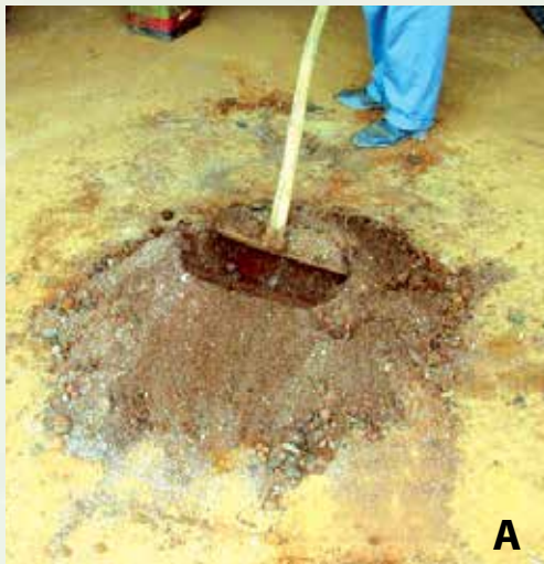
Figura 7. Mistura dos componentes do substrato, com (a) enxada e (b) betoneira
